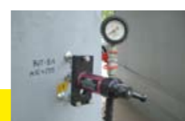
Натурные испытания на объекте (шпилька М10х135, установка в колонну из тяжелого бетона, максимальная нагрузка на вырыв 30,7 кН)
